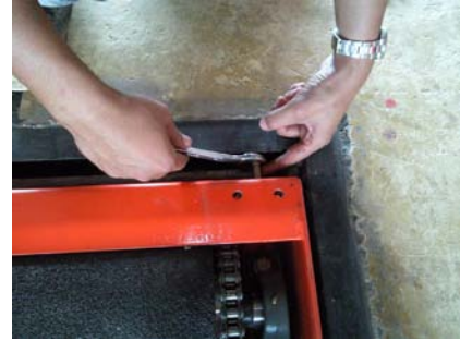
รูปที่ 43 ขันน็อตปรับระยะช่องว่าง ระหว่างเครื่องกับโครงหลุม ให้ห่างประมาณ 3-4 มม. ทุกด้าน
